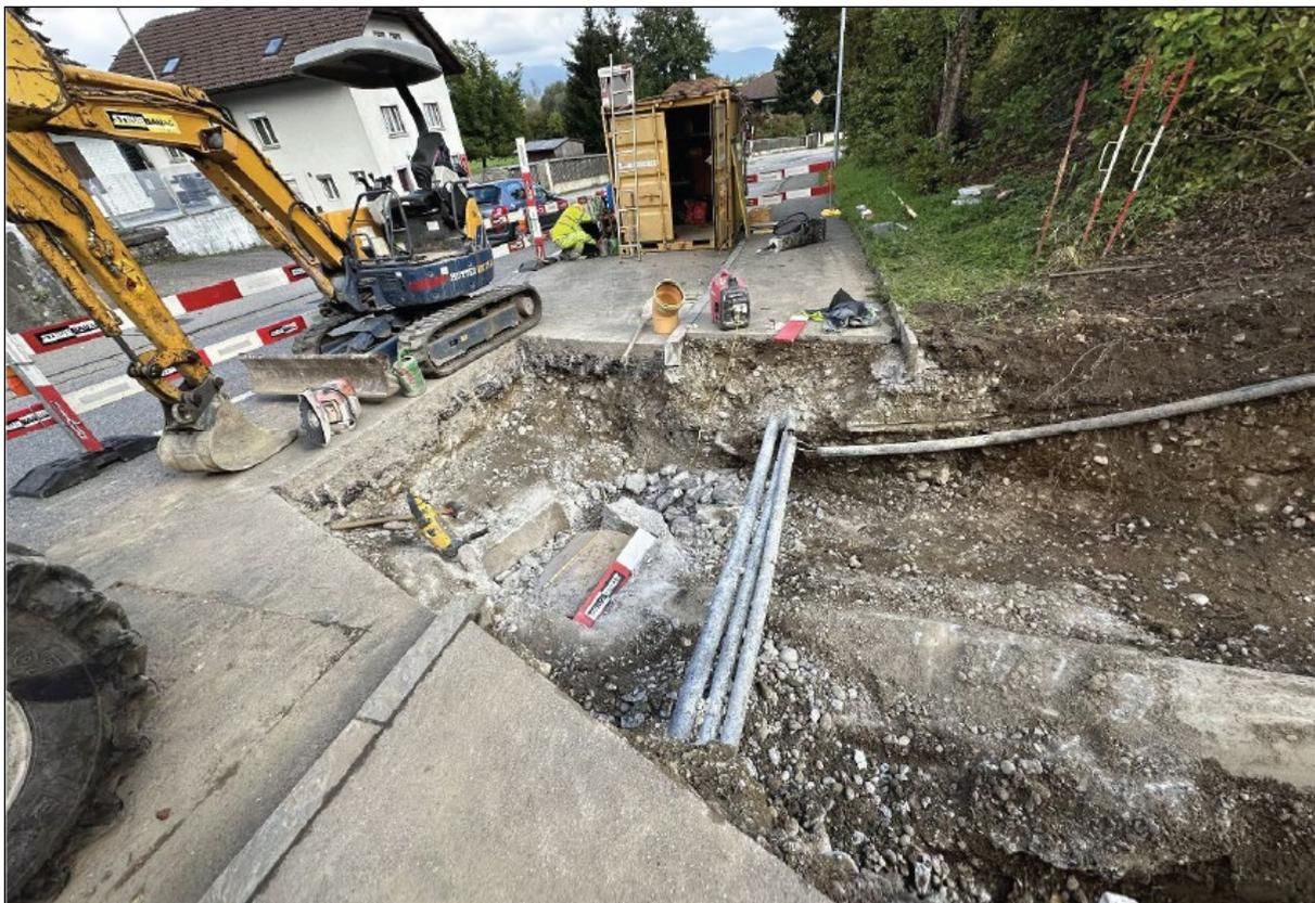
Abbildung 4: Sanierungsmassnahmen Abwassereinbindung Kantonsstrasse
