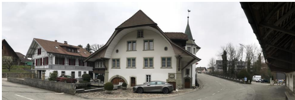
Abb. 14 Ansicht Obermurgenthal (Quelle: Gruner)
