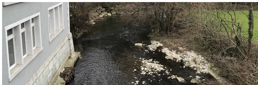
Abb. 22 Die Murg im Bereich Obermurgenthal (Quelle: Gruner)
