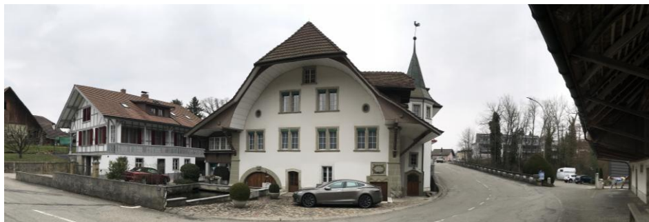
Abb. 14 Ansicht Obermurgenthal (Quelle: Gruner)
