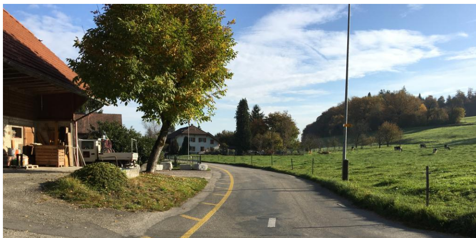
Abb. 16 Aarwangenstrasse mit Fussgängerlängsstreifen, welcher im Rahmen der Strassensanierung durch ein bauliches Trottoir ersetzt wurde (Foto: Gruner)
