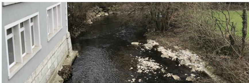
Abb. 22 Die Murg im Bereich Obermurgenthal (Quelle: Gruner)
